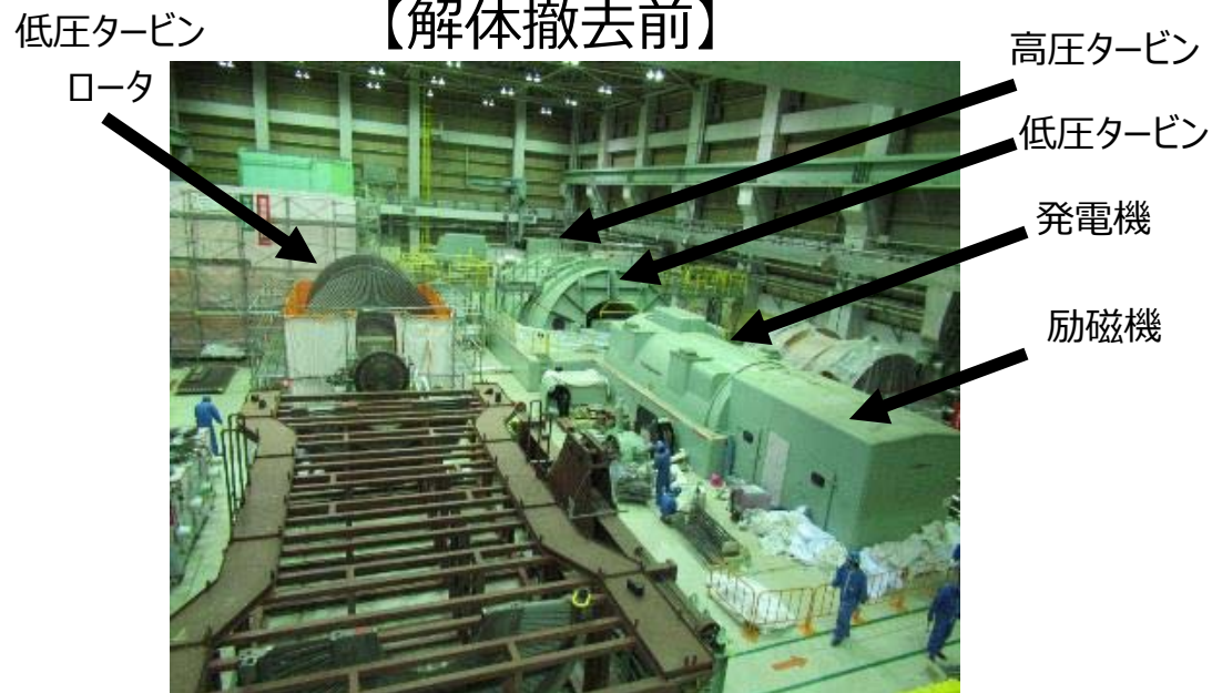
低圧タービンロータ解体前
