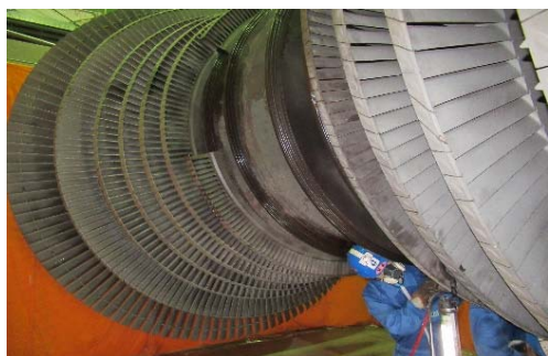
低圧タービン羽根車撤去作業の様子
