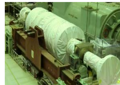
低圧タービンロータ解体後
