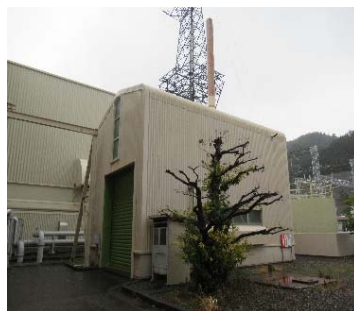
②補助ボイラー建屋
