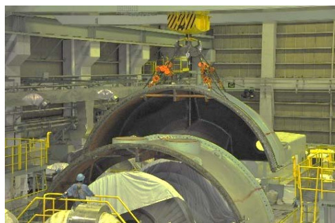
タービン車室吊上げ作業の様子
