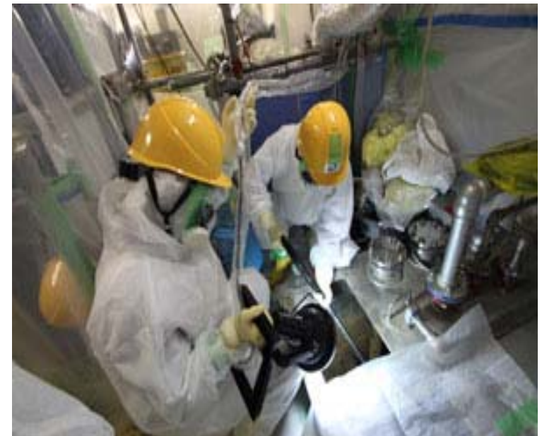
【除染作業風景】
