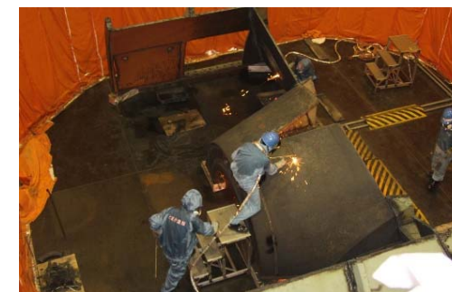
管理区域内での撤去物小割作業の様子
