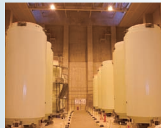
【参考】東海第二発電所における乾式キャスクの例
