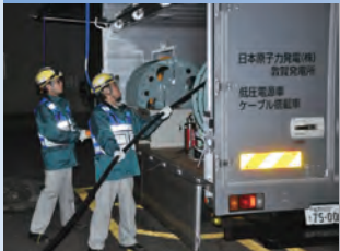
ケーブル搭載車からケーブルの引き回し夜間訓練
