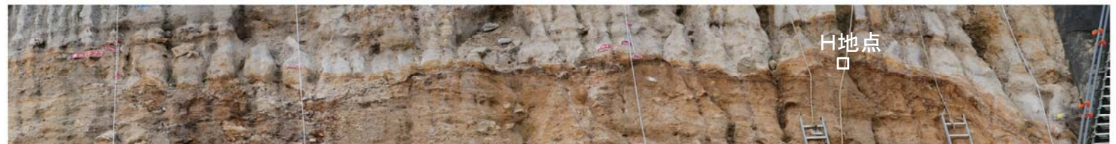
D-1トレンチ北法面 土壌分析試料採取位置
