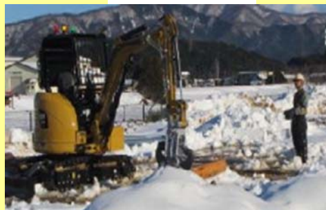
無線重機訓練
