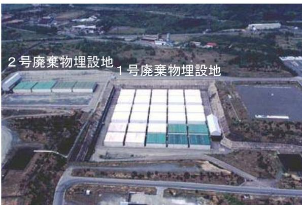
1号廃棄物埋設地には、均質固化体（均質固化体とは、原子力発電所の運転に伴い発生した廃液等を濃縮処理した後、セメントまたはアスファルトとともにドラム缶内に充填し均質・均一に固型化したもの）を、2号廃棄物埋設地には、充填固化体（原子力発電所の定期検査時等の工事に伴い発生した低レベル放射性廃棄物であって、金属類、プラスチック、保温材、フィルタ等の固体状廃棄物を種類毎に分類し、熔融処理又は必要に応じて切断・圧縮処理を行った後、ドラム缶に収納し、セメント系充填材（モルタル）を充填し固型化したもの）を埋設する。
