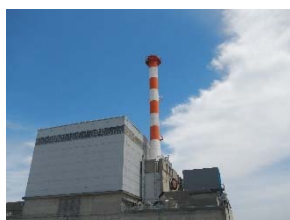
東海発電所 排気筒短尺化工事
