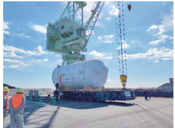
フィルタ付ベント設備の搬入
