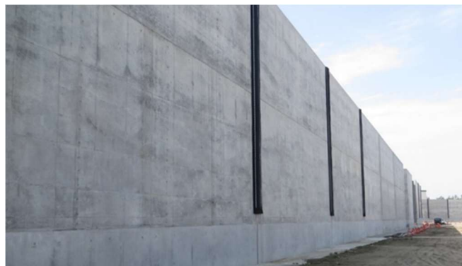
防潮堤設置工事
