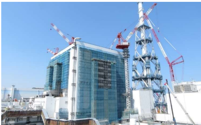
主排気筒の耐震性向上及び 原子炉建屋の安全機能向上工事
