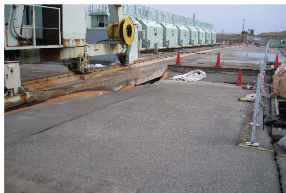
写真④(取水口エリア)
