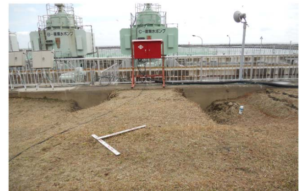
写真②(循環水配管埋設エリア)
