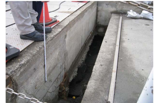
写真⑤(取水口エリア)
