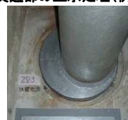
貫通部の止水処理(例)
