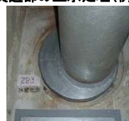
貫通部の止水処理(例)
