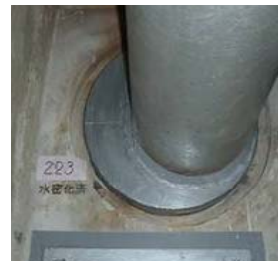
貫通部の止水処理(例)
