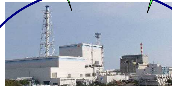
東海・東海第二発電所
