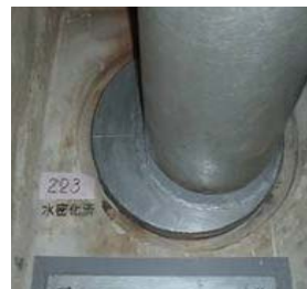
貫通部の止水処理(例)
