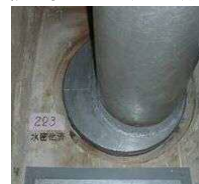
貫通部の止水処理(例)
