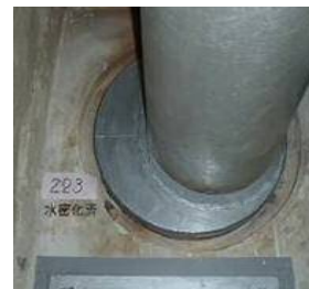
貫通部の止水処理(例)
