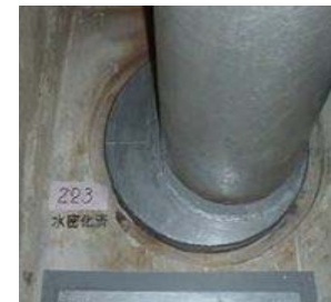
貫通部の止水処理(例)
