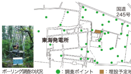
ボーリング調査の状況
