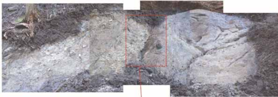
写真1 道清右岸側斜面露頭（スケッチ箇所）
