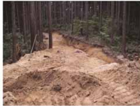
写真2 トレンチ全景 (北東端から撮影)
