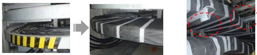
防火シート施工前後
