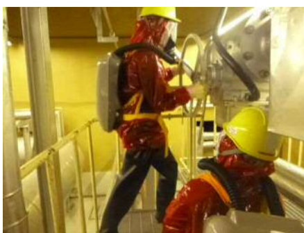
現場手動隔離操作 (放射線防護具装着)
