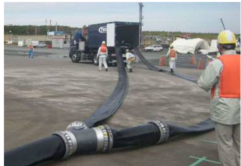
東海港での送水訓練 (ホース敷設)
