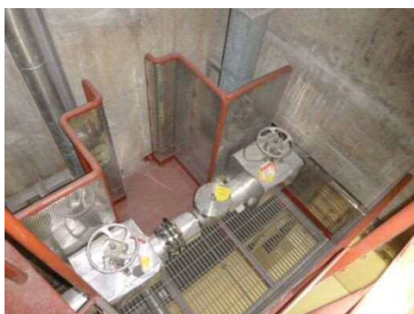
作業場所（全体）
