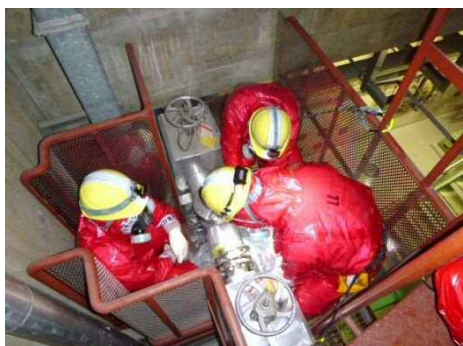
連絡配管閉止フランジ切替訓練
