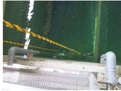
吊り下ろし作業
