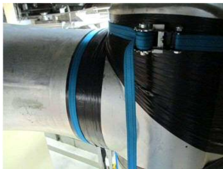
第3図 修復模擬作業状況
