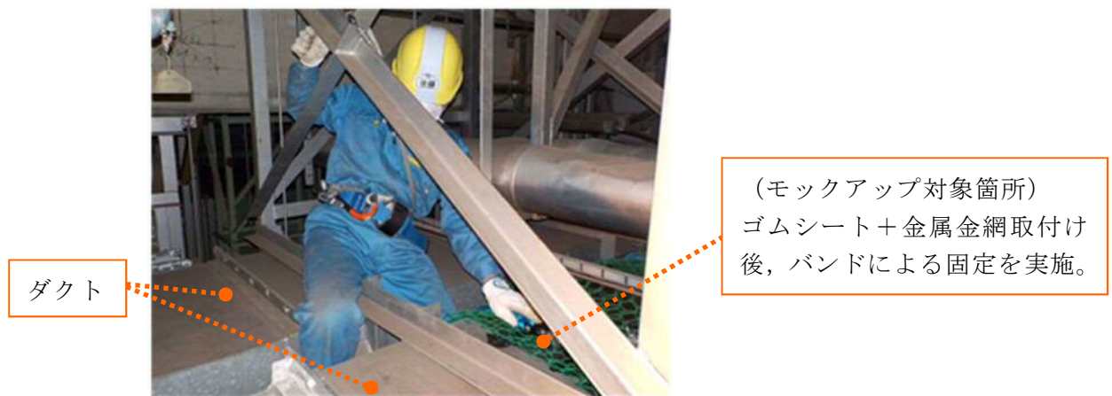
第5図 狹隘部作業状況
