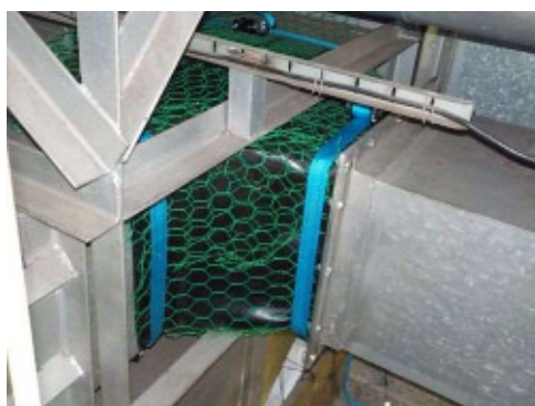
中央制御室空調ダクト分岐部における修復方法 ・ゴムシート+金属金網（メッシュ）により補修、バンドにて固定
