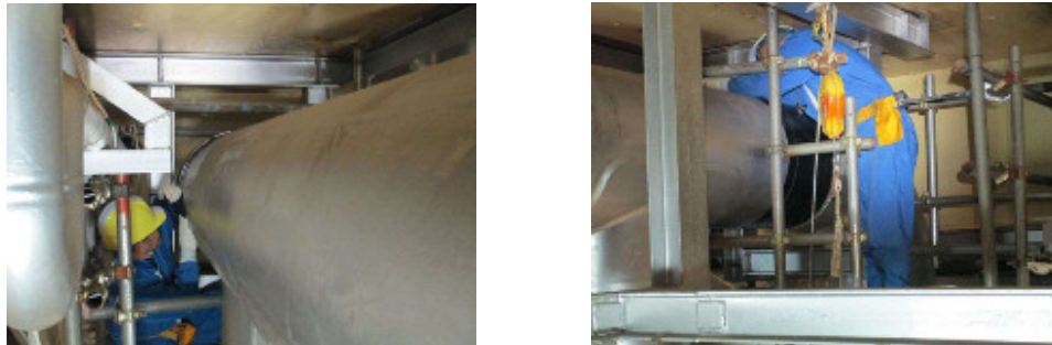
第2図 狭隘部作業状況
