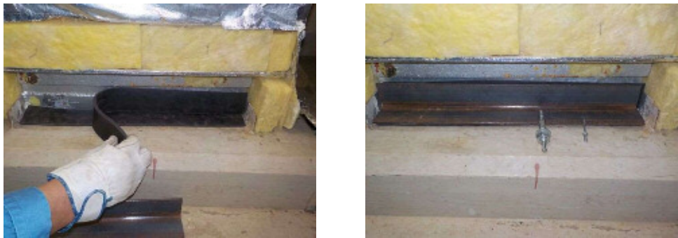
第7図 床貫通部模擬作業状況
