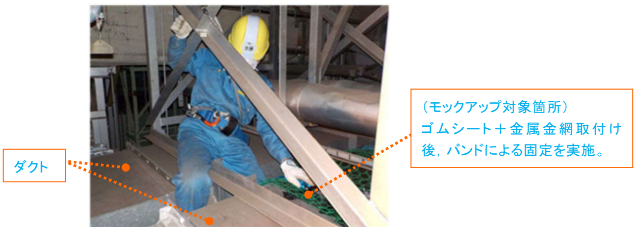
第5図 狭隘部作業状況
