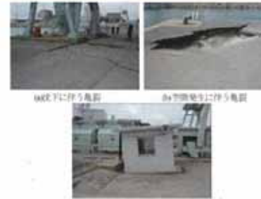
図-4.4.3 取水口周辺の地震被害事例
