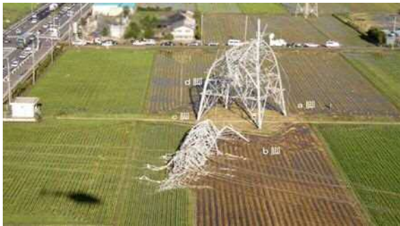
強風による鉄塔の倒壊事例①※ 1
