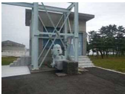
T/H 消火用ディーゼルポンプ室
