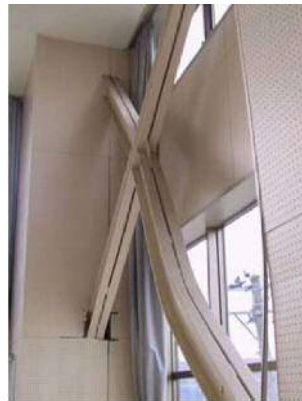
間柱脚部アンカーボルト破断
