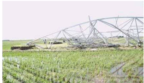
強風による鉄塔の倒壊事例②※ 1
