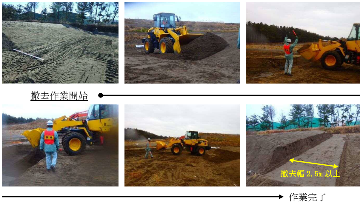
第 8 図 土砂撤去検証の写真
