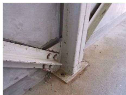
間柱脚部アンカーボルト破断
