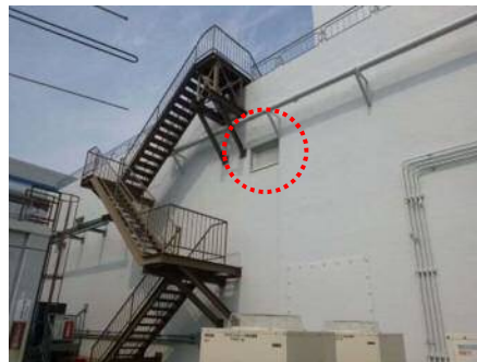
図2 外気取入口（中央制御室換気空調系）
