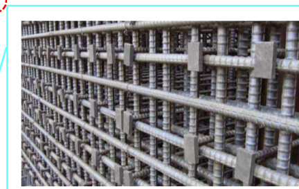
梁壁部鉄筋のイメージ
