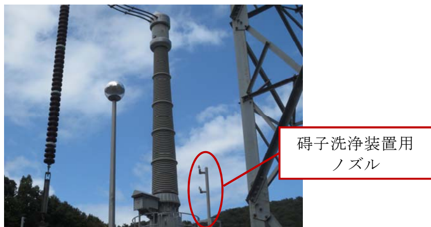
第 2.2.4.6-1 図 碍子洗浄装置外観（イメージ図）
