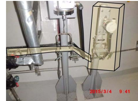
格納容器圧力伝送器(PT-26-79.51A)
