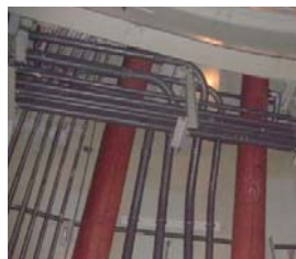
ケーブルは電線管敷設
