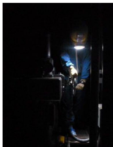
(可搬型照明を使用した 状態での作
