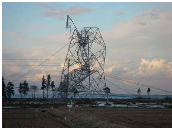
津波による隣接鉄塔の倒壊に伴う送電鉄塔の倒壊事例※2
