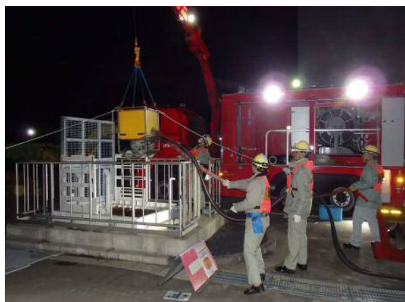
(暗所環境下での作業状況の例)
