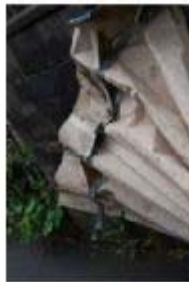
飛散した折板屋根の損傷状況
