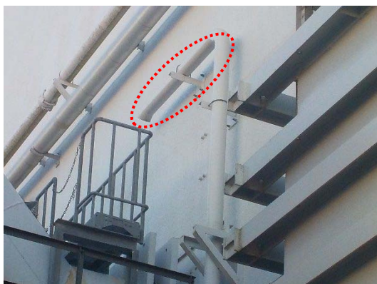
第 3 図 ディーゼル駆動消火ポンプ排気管
