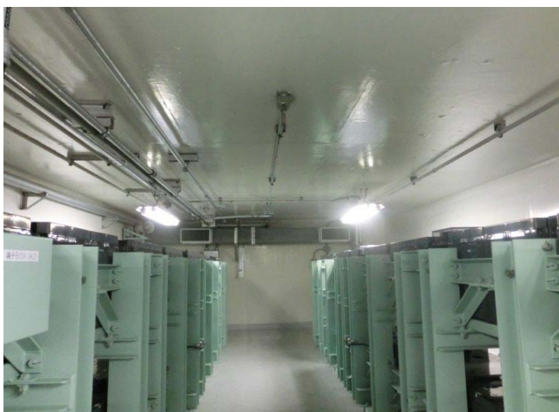
第41-1-6図 水素濃度検知設備の例
