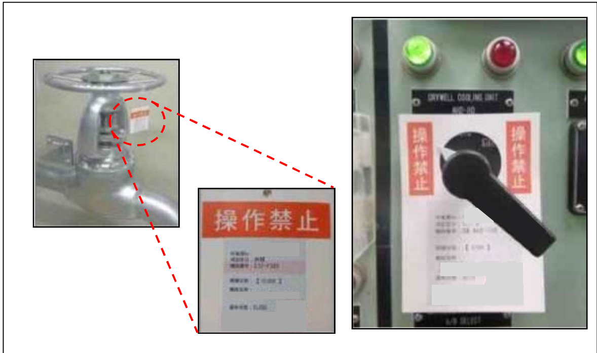
第 2.4.3-1 図 操作禁止札による識別（例）
