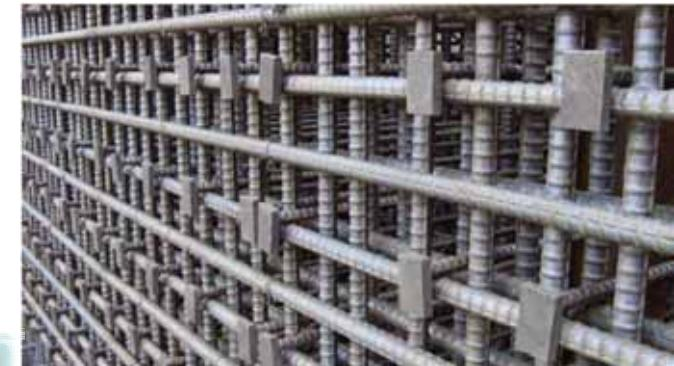
壁部材への適用状況
