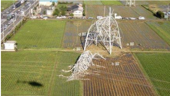
強風による鉄塔の倒壊事例①※ 1
