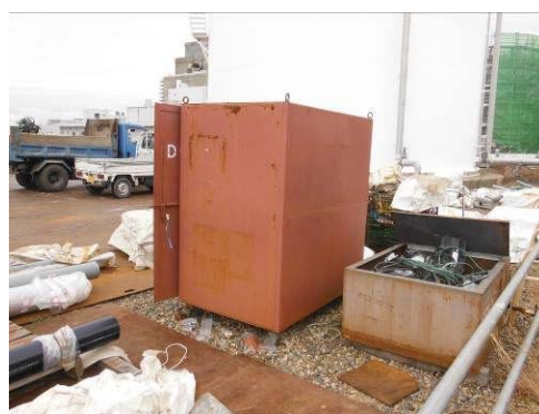
#62 鋼製ボックス
