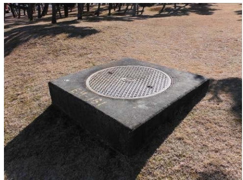
#186 マンホール蓋
