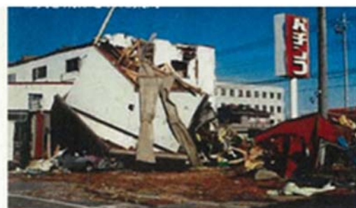
吹き飛ばされた建物
