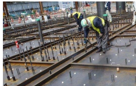
スタッドの施工状況
