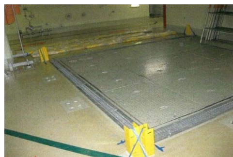
支柱レールの取付状況
