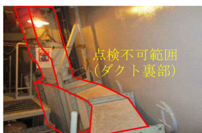
図 5. 1 今回定めた目視試験条件が確保できない範囲（代表例）
