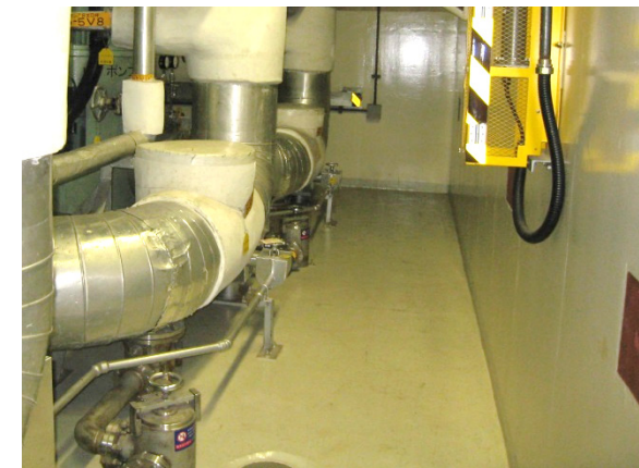
タービン建屋 基礎マット
