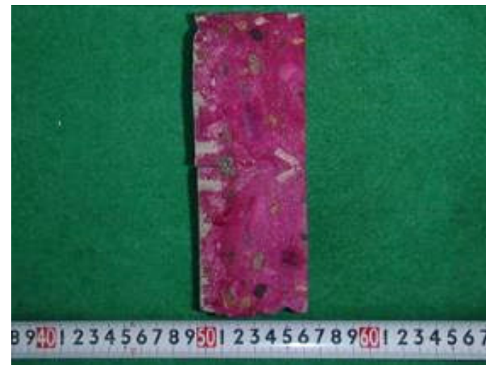
中性化深さの点検状況
