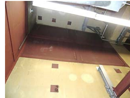
室内よりの状況 (3階 3F2)
