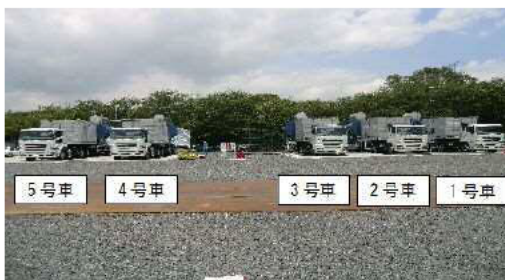
常設代替高圧電源装置（イメージ）
