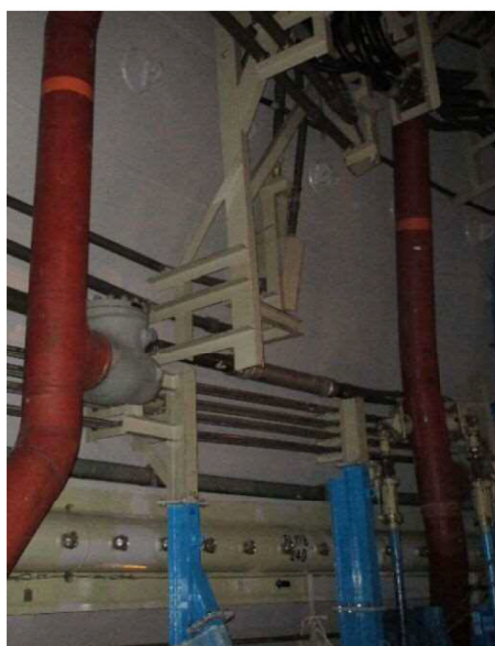
仮設足場組立前
