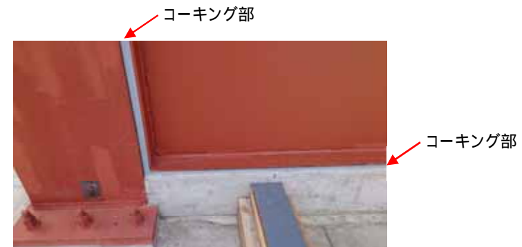
コーキング施工状況(パネル下部)
