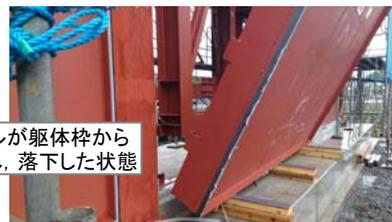
パネルが躯体枠から脱落し、落下した状態
