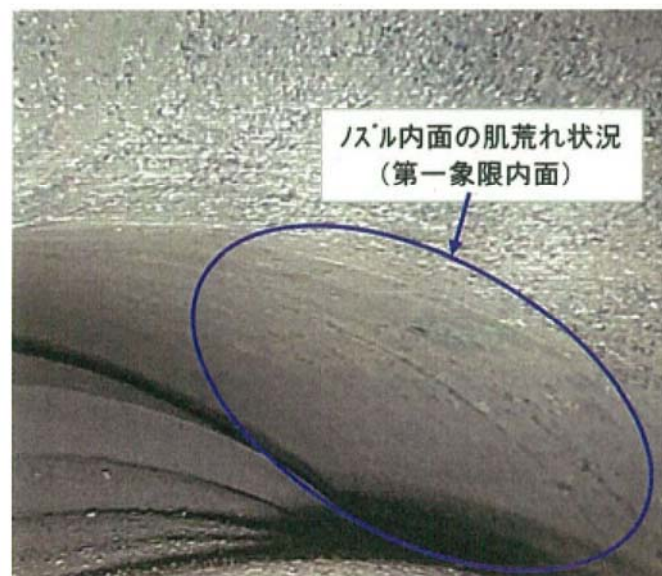
図 4. 2. 2 給水ノズルコーナー部表面状態（例 給水ノズル A）
