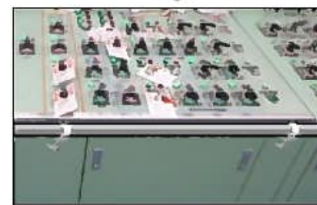
対策後設備 (手摺設置イメージ) 主制御盤への手摺の設置
