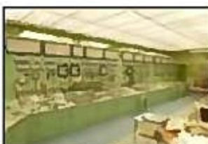
③タービン・発電機及び 所内電源系制御盤
